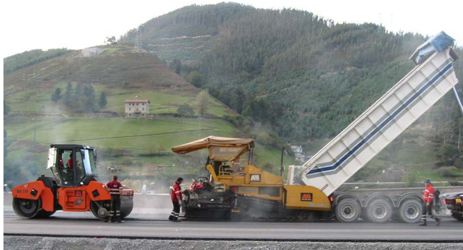
Imagen 1. Trabajos de asfaltado. Fuente: http://www.asfaltosuribe.com/empresa/recursos/rrhh
